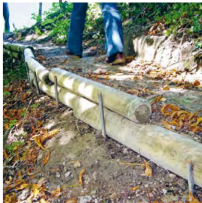
contenimento testa scarpata
