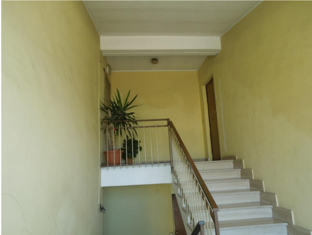
Foto 13: Caratteristiche dei locali condominiali – scala interna condominiale e struttura portante
