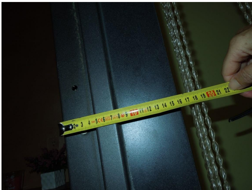
Foto 16: Caratteristiche dell'involucro – caratteristiche dei Portoncini di ingresso agli appartamenti
