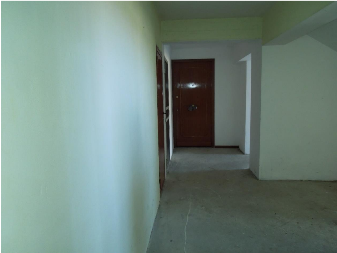
Foto 9: Caratteristiche dei locali condominiali – corridoio al piano terra
