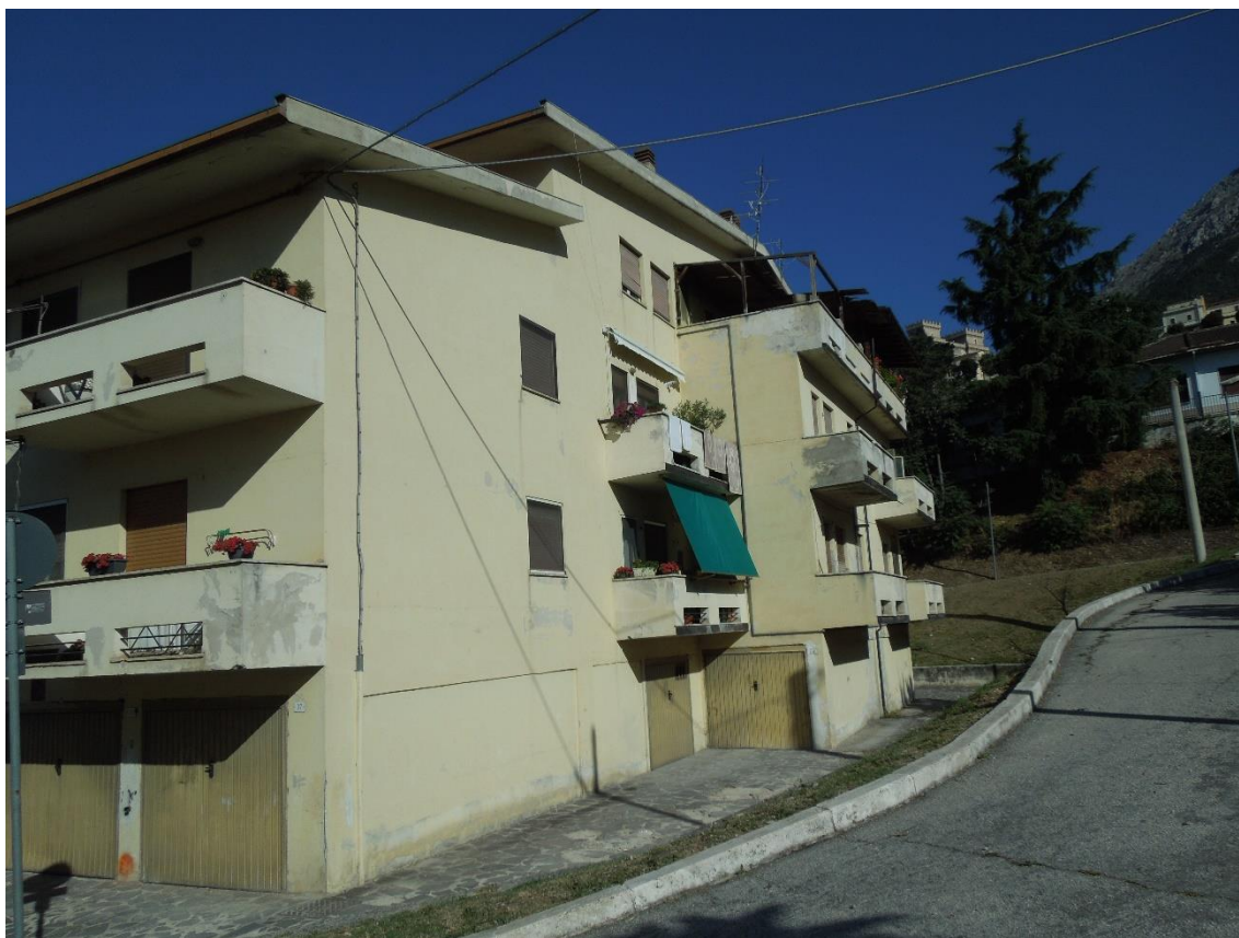
Foto 4: Involucro termico opaco e trasparente con elementi perimetrali
