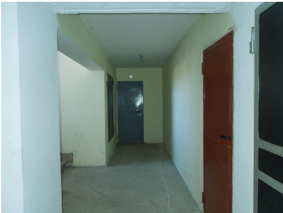
Foto 8: Caratteristiche dei locali condominiali – corridoio di accesso ai locali non riscaldati
