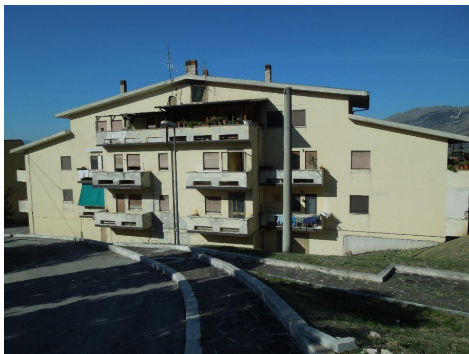
Foto 2: Involucro termico opaco e trasparente con elementi perimetrali – Prospetto posteriore
