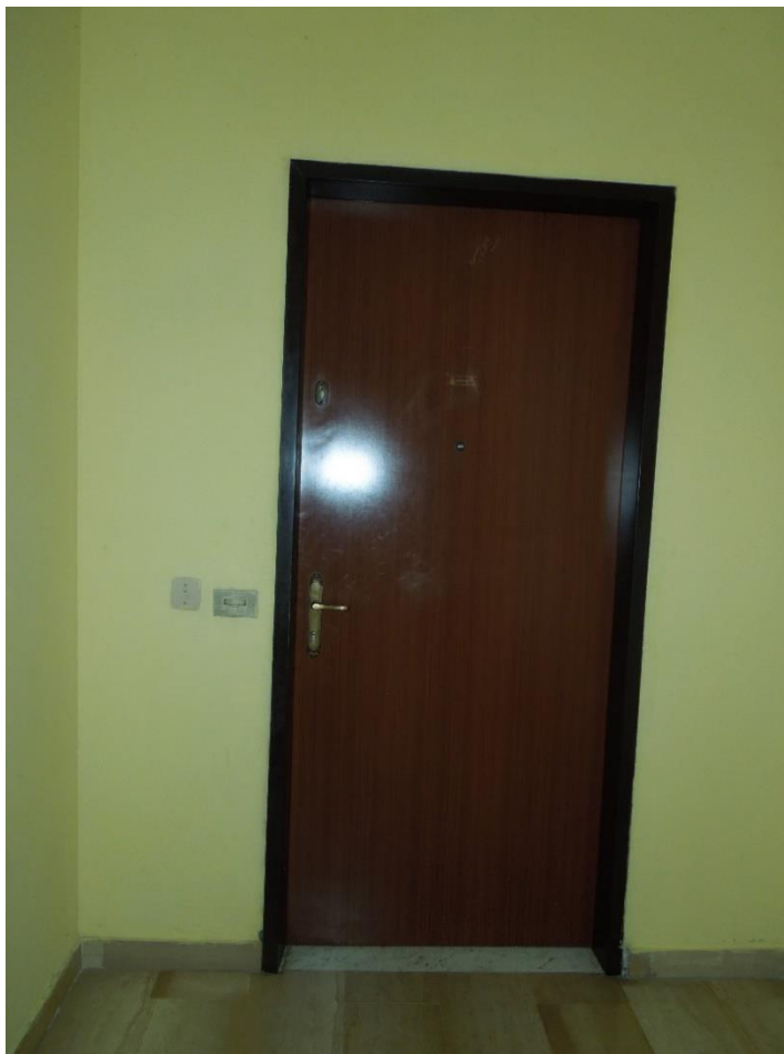
Foto 15: Caratteristiche dell'involucro – caratteristiche dei Portoncini di ingresso agli appartamenti
