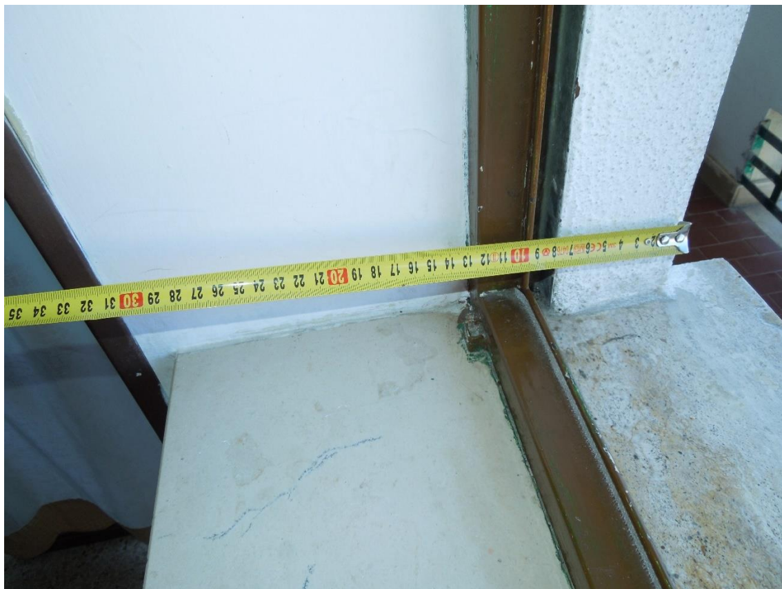
Foto 25: Involucro termico opaco e trasparente con ponti termici – spessore murature esterne
