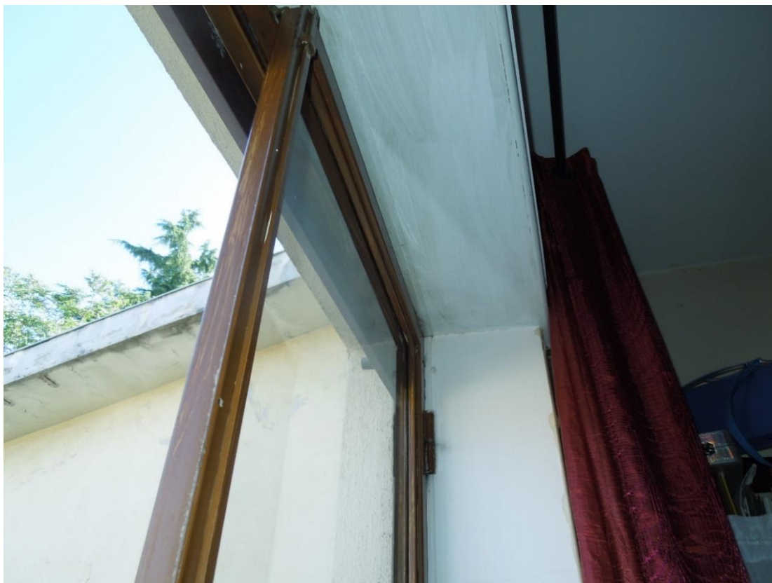
Foto 22: Involucro termico opaco e trasparente con elementi di nodo cassonetto
