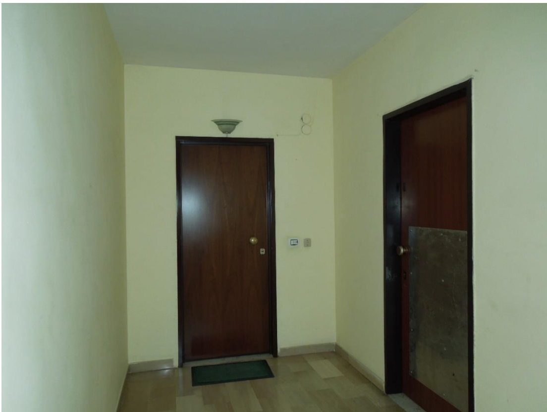
Foto 10: Caratteristiche dei locali condominiali – androni condominiali e portoncini di ingresso agli appartamenti
