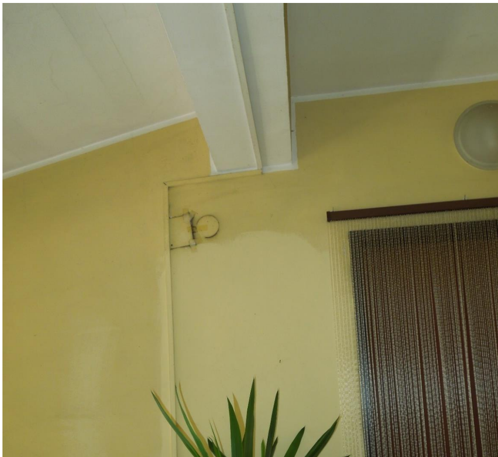
Foto 14: Caratteristiche dei locali condominiali – scala interna condominiale e struttura portante
