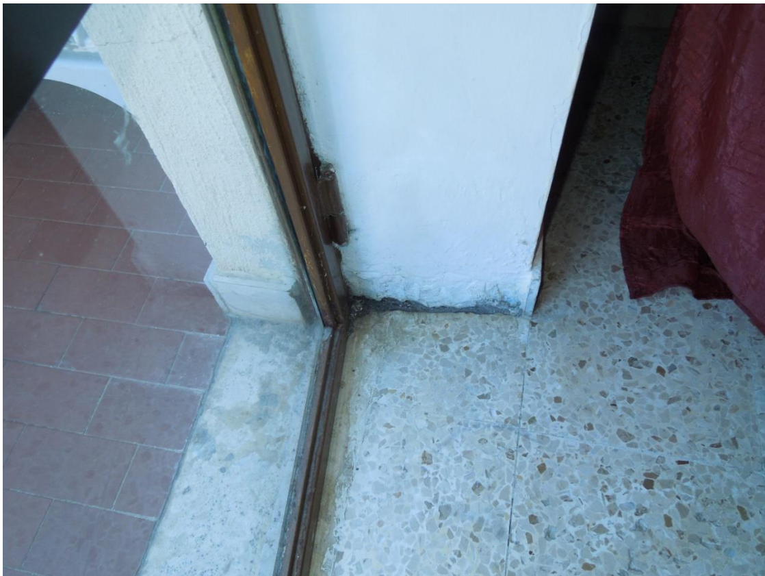
Foto 20: Involucro termico opaco e trasparente con elementi di nodo finestra – soglie passanti
