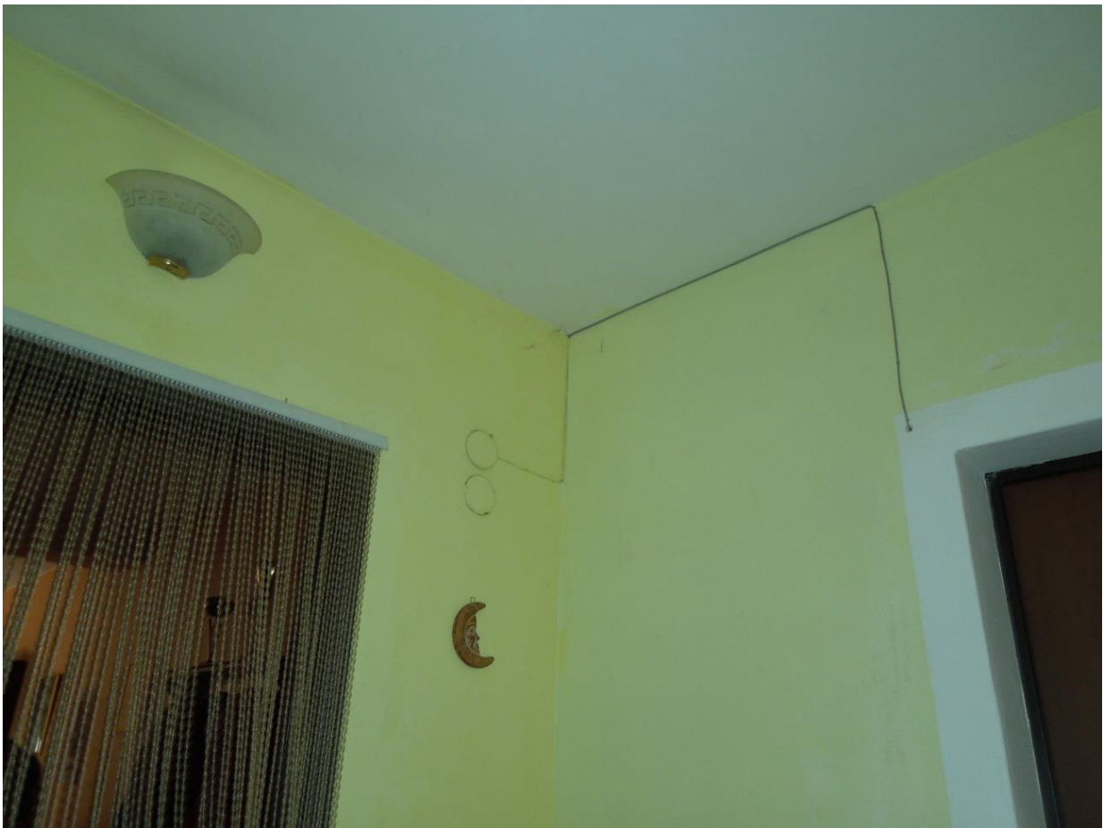
Foto 32: Stato di manutenzione – impianto elettrico
