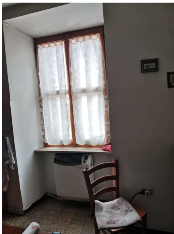
Foto 7: Caratteristiche dei serramenti – Infisso in legno con vetro singolo
